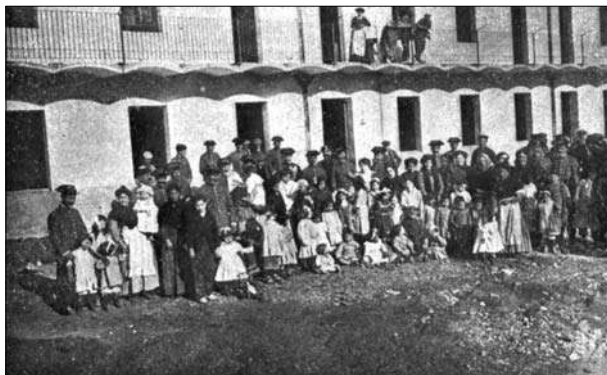
Patí interior de la caserna de la Guàrdia Civil de Terrassa durant la cerimònia de benedicció, el 12 de gener de 1912
