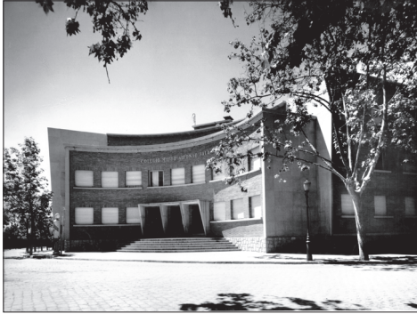
Façana principal de l'antic Col·legi Major Alfons Sala, situada al xamfrà del carrer de Colom i de l'avinguda de Jacquard.
